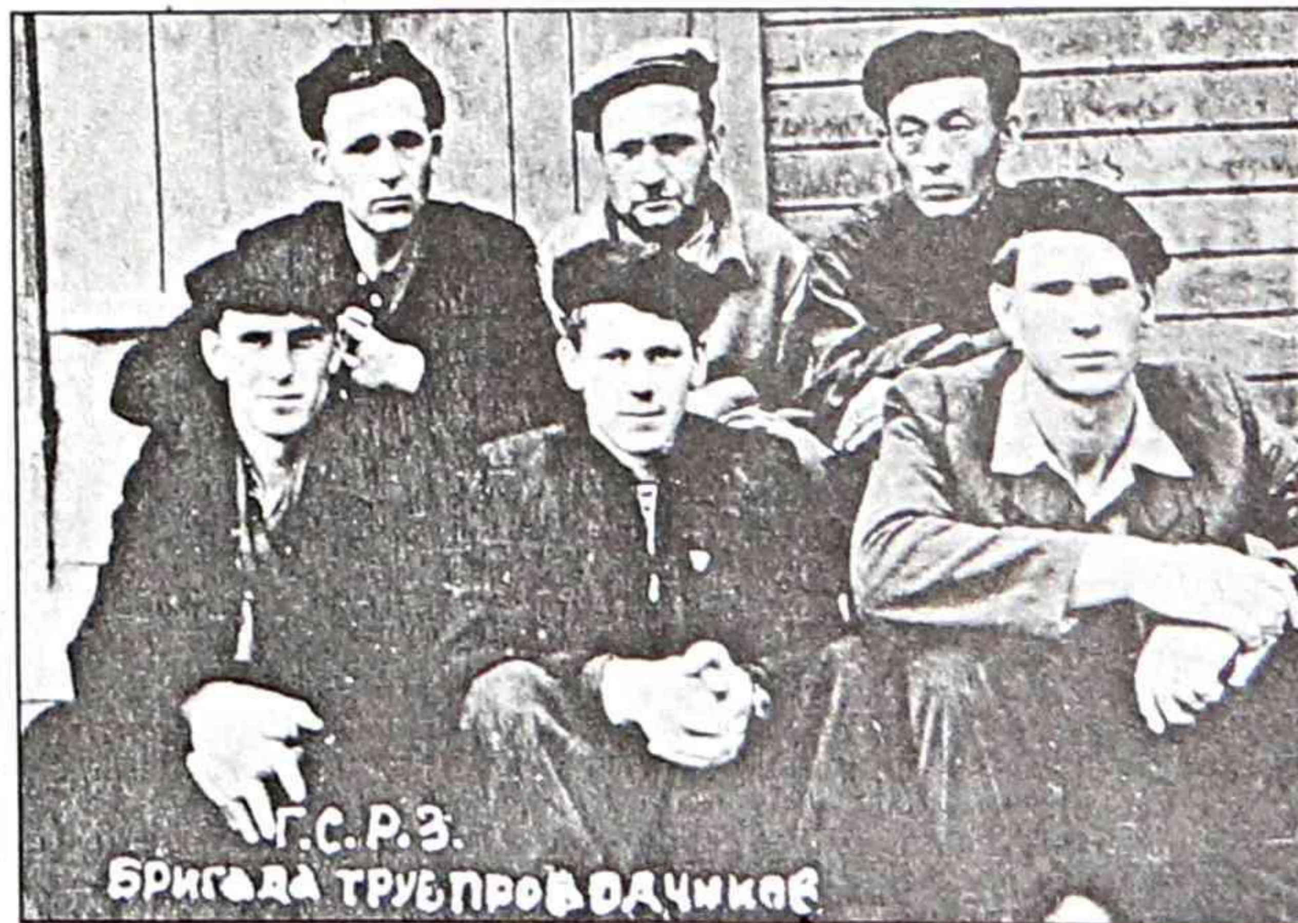
Бригада трубопроводчиков. 1957 г.
