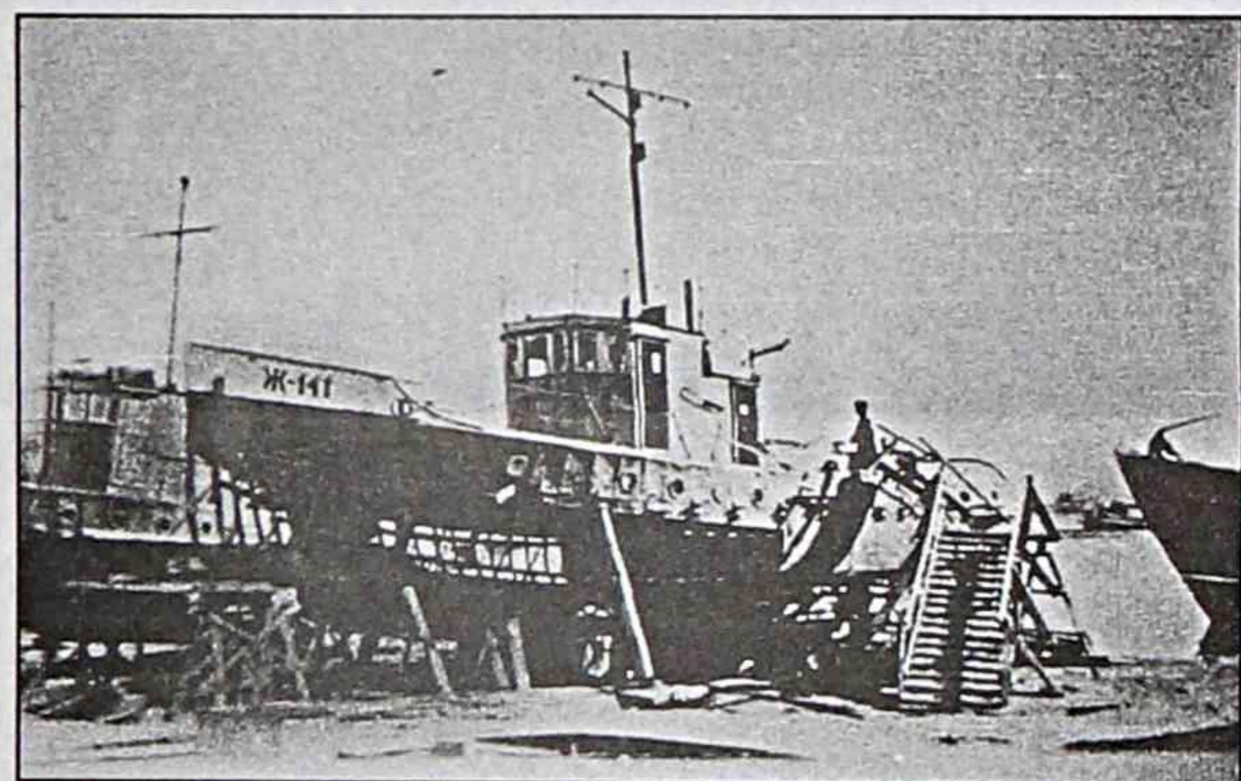
Капитальный ремонт катера Ж-141
