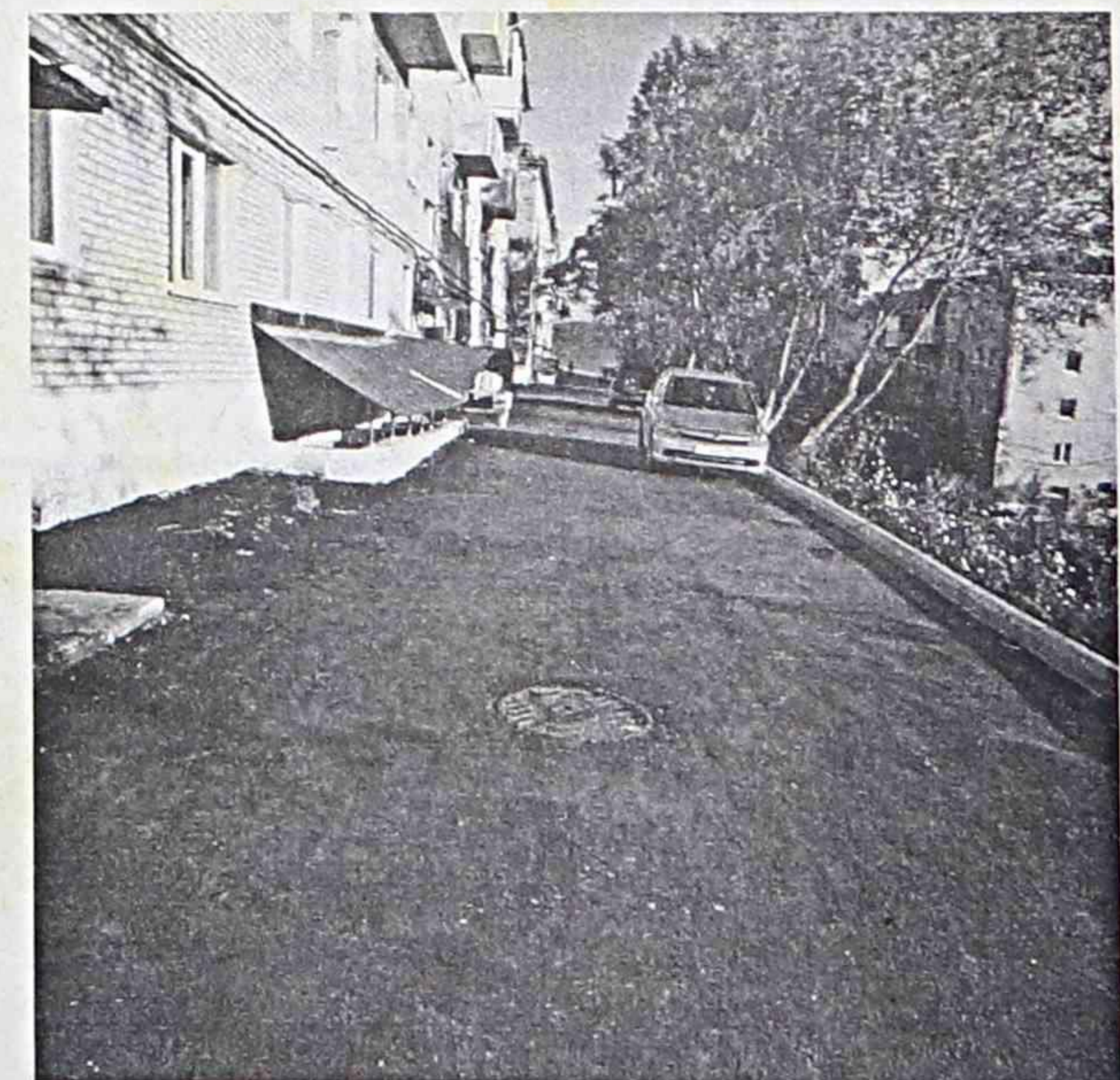
Асфальтирование придомовых территорий в п.Южно-Морской
