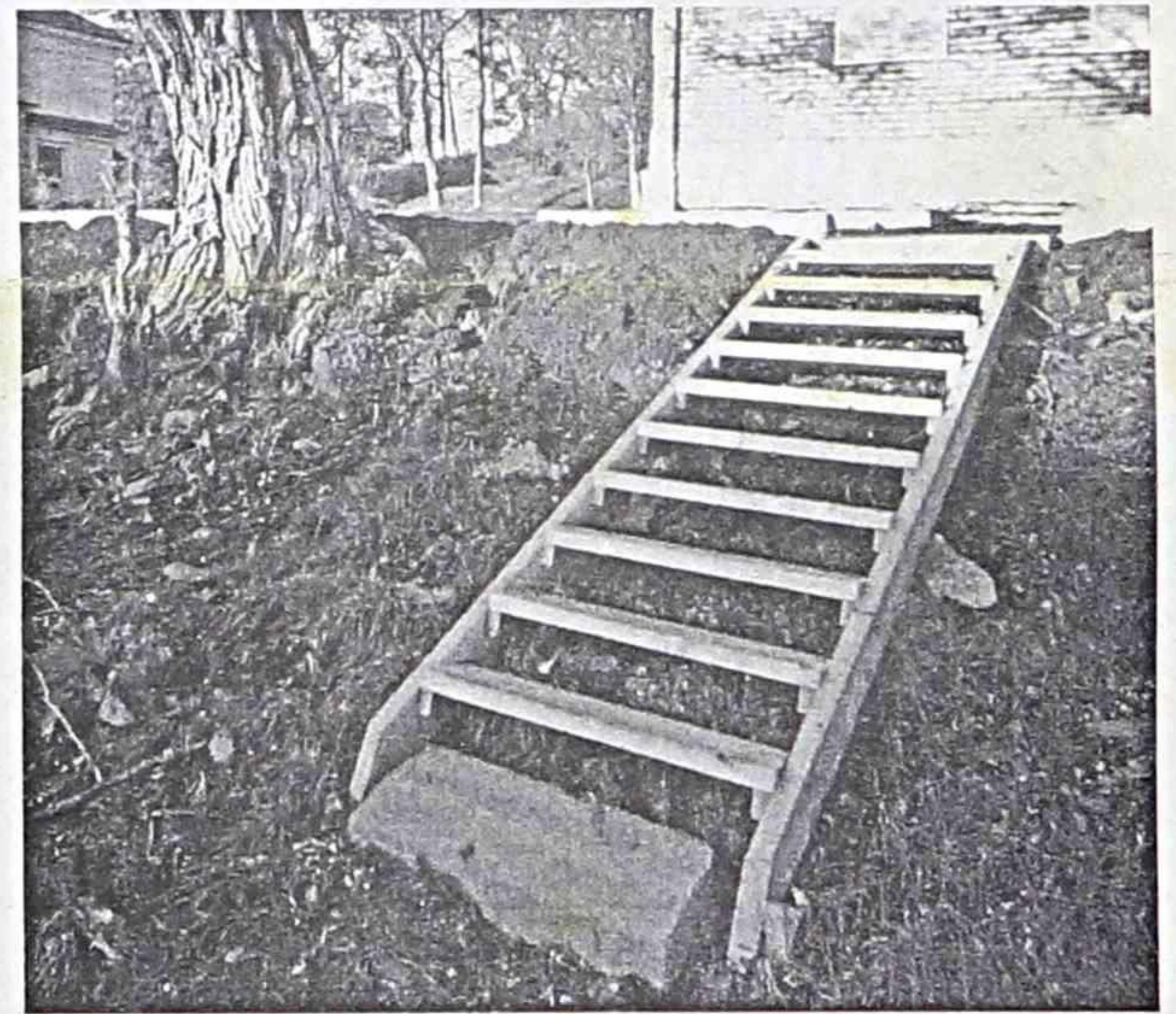
Ремонт, изготовление и установка лестничных переходов между домами
