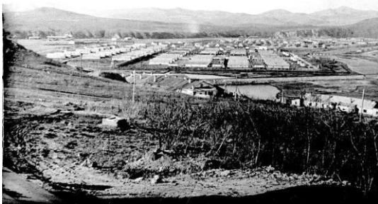
Строительство № 213. Панорама транзитного лагеря
