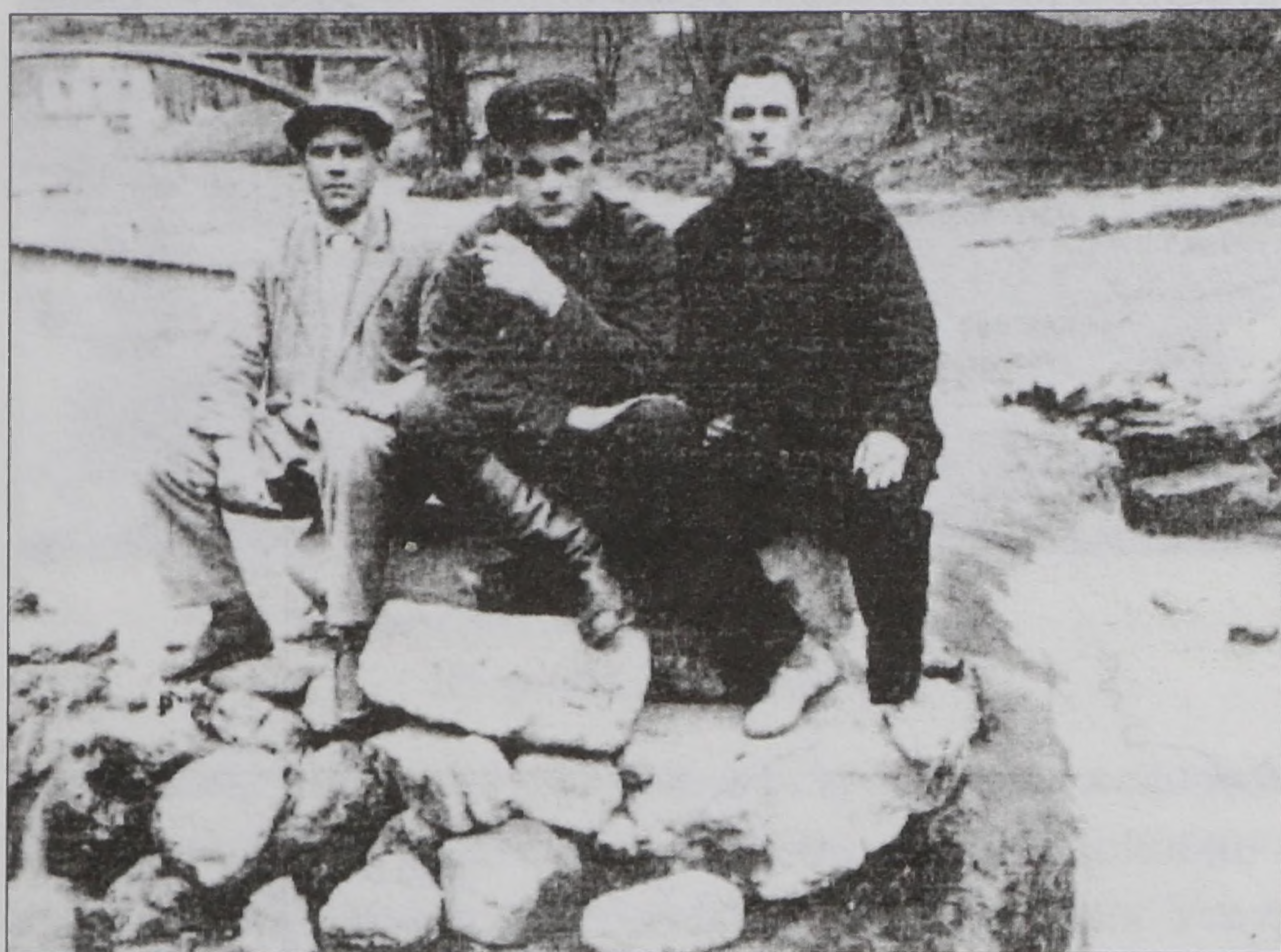
Строители ж/д к б/х Находка. В центре – комиссар 2 ранга Ремнев Л.Г. Фото 1934 г.
