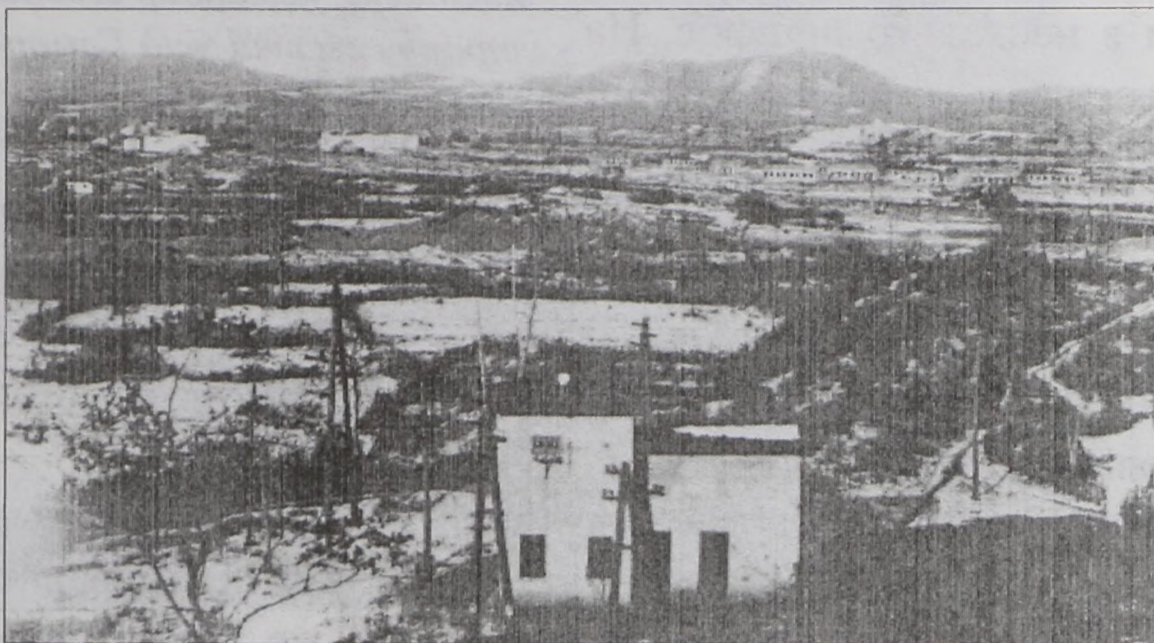
Общий вид на ж/д ст. Гамарник. Фото 68,2551 унци.
