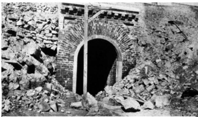
Бетонирование южного входа №2 в главную галерею
