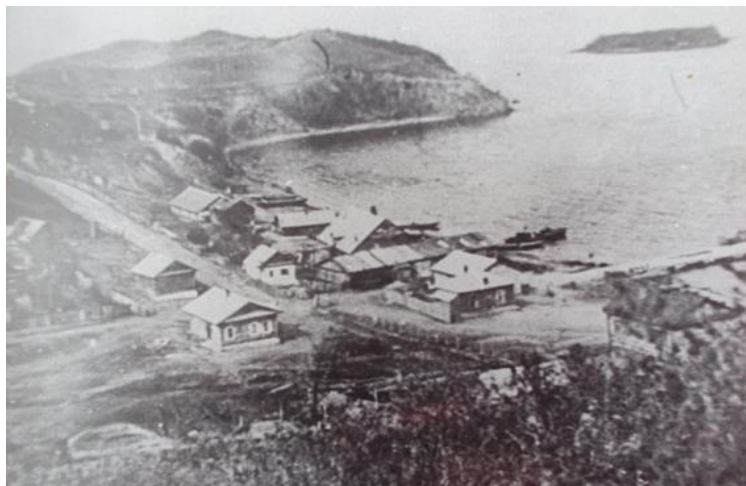
Район Управления торгового порта. Частные дома переселенцев 1915 г. Справа остров Новицкого. 1931 г. (фонды МВЦ г. Находка)
