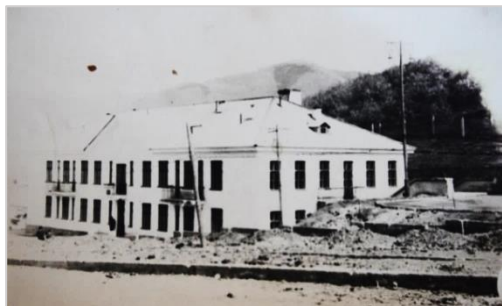
Строительство поликлиники на ул. Пирогова.
