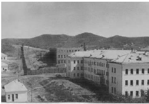
Строительство городской больницы №3, главный корпус, бо-е г
