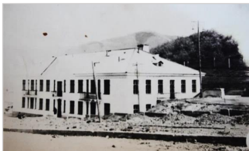
Строительство поликлиники на ул. Пирогова.
